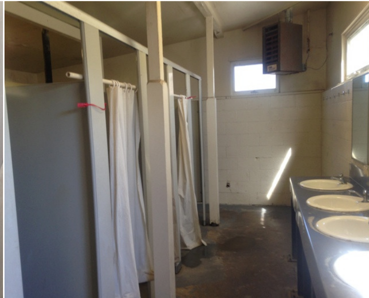
Privacy curtains in lieu of doors
